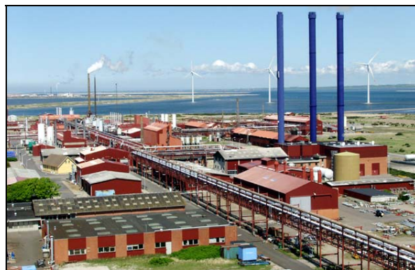
Produktionsanlægget på Rønland.
