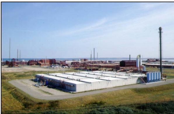
Biologisk rensningsanlæg på Rønland.
